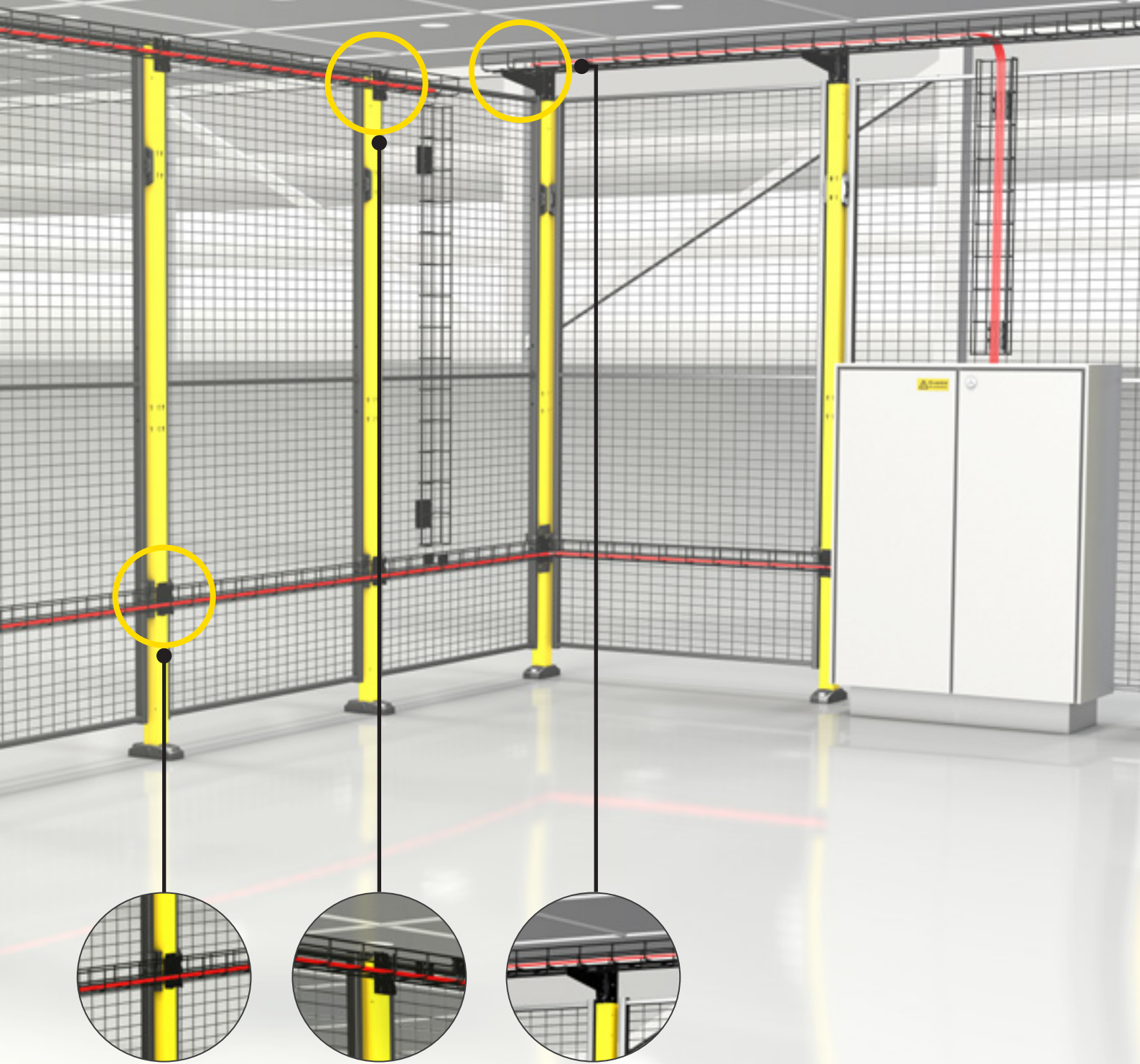
Befestigung an der Bodenstütze
