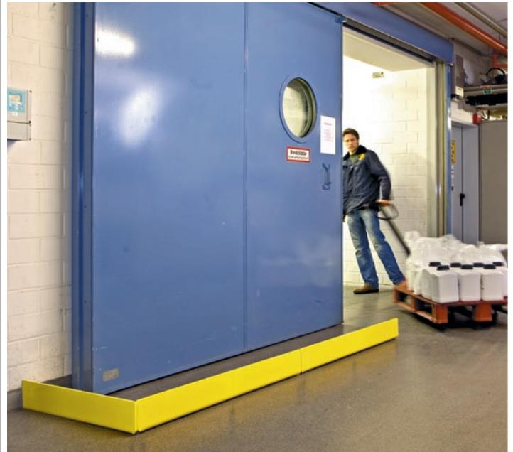
Häufig werden Lager-, Brandschutztüren und -tore beschädigt. Ursache: In der Sperrfläche im Rückfahrraum wurden Paletten/Gitterboxen abgestellt. Auch durch Staplerfahrer, die in diesen Bereich einfahren, während sich das Tor öffnet, können Schäden verursacht werden.
