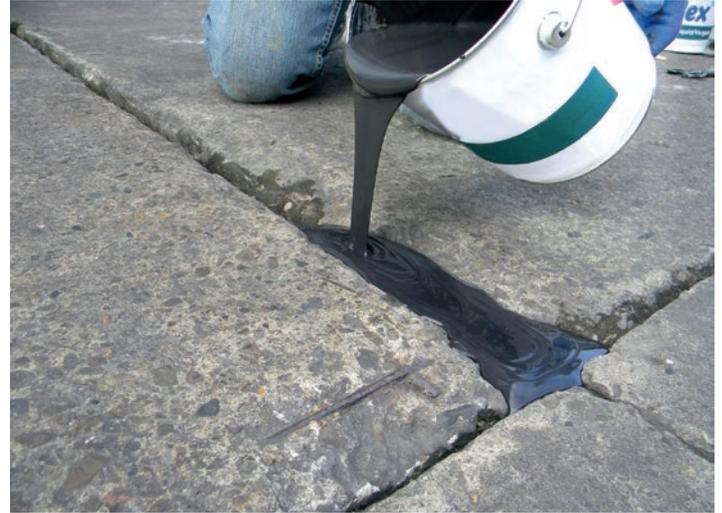
Extrem belastbares und beständiges Zweikomponenten-Gemisch mit schnellreaktivem Bindemittel für kurze Aushärtezeiten.
